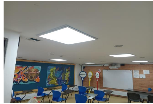
CAMBIO DE LUMINARIAS
